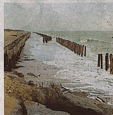
À Blainville-sur-Mer, la première rangée de pieux destinée à briser l'énergie des vagues a été déplacée au cours du mois de janvier 2025. | PHOTO : OUEST-FRANCE
